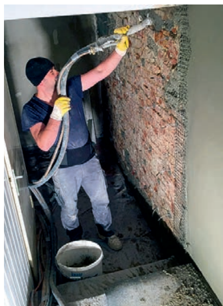
(11) Auftrag eines mikrokristallbildenden Abdichtungsmörtels
