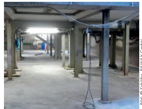
(7) Fertiggestellte Innenwanne mit flügelglätteter Aufbetonsohle
