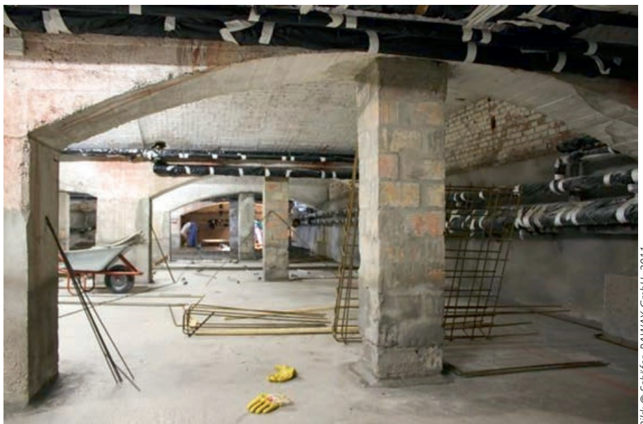
(1) Nachträglicher Einbau einer Betoninnenwanne gegen drückendes Wasser
