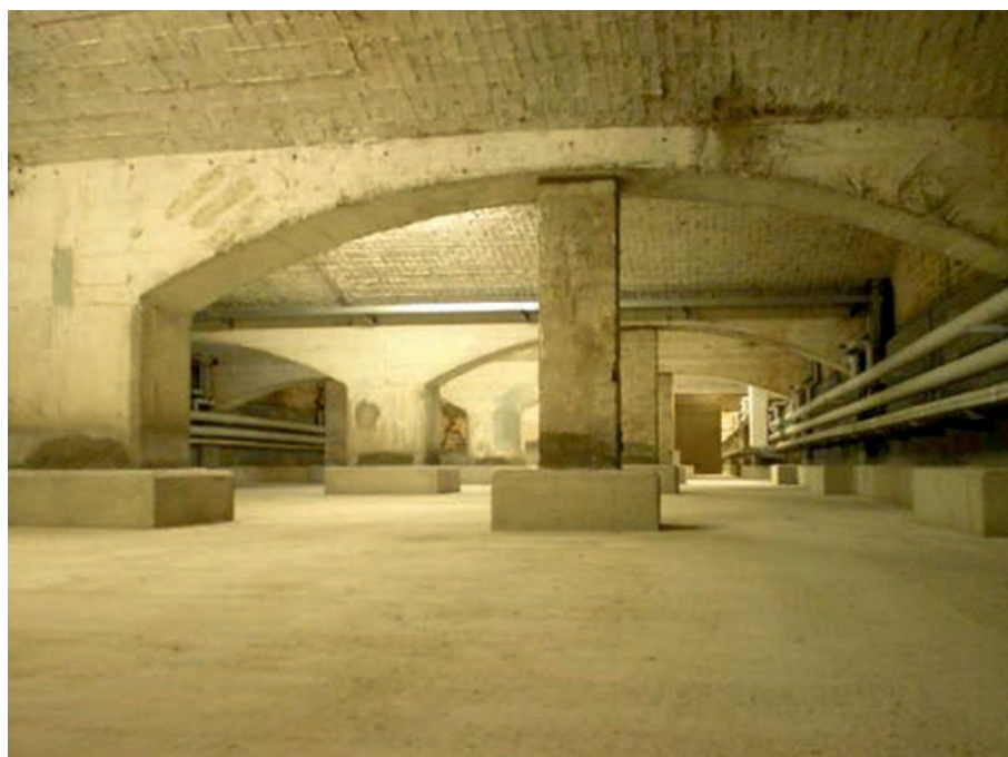
(5) 1.200 m 2 nachträglich eingebaute Betoninnenwanne teilweise mit reduziertem Querschnitt und Aufbetonsohle im Verbund
