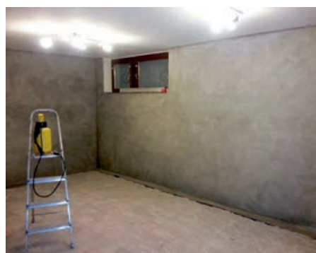
(12) Fertiggestellte Textilbetoninnenwanne
