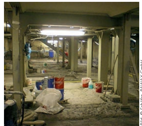
(6) Vorabdichtung zum Einbau einer Aufbetonsohle im Verbund
